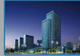
Seguridad en Red: Edificio
